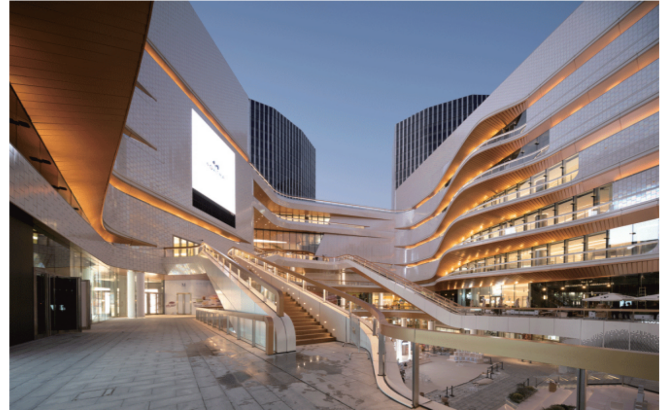
上海 闸北久光中心
