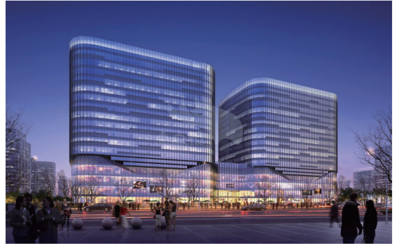
杭州 新天地中心
