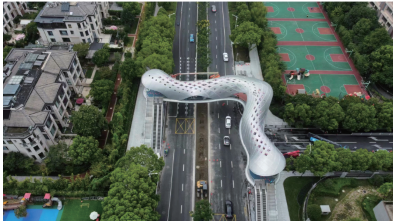
杭州 滨江育华巷天桥
